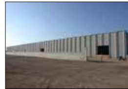
Nuovo stabilimento "Umbra Cuscinetti" (mq 25000) in Loc. Paciana - Foligno Committente: Manini Prefabbricati S.p.a. Importo lavori: € 3.202.032,77
