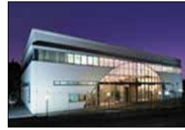
Edificio prefabbricato sede "Nonsolobella Srl" (mq 2000) 1993 Loc. S. Eraclio - Foligno (PG)
