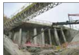
Opere di consolidamento della frana sotto la piattaforma di carico del frantoio Loc. La Piastra - Carrara 2003 Committente: OMYA S.p.a. Importo lavori: € 280.000,00 Progetto Preliminare, Definitivo ed Esecutivo e Direzione Lavori
