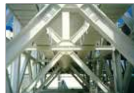
Fabbricato nuovi carichi Slurry e Polveri in Loc. Avenza - Carrara 1997 Committente: OMYA S.p.a. Importo lavori: € 697.216,00 Progetto preliminare, definitivo ed esecutivo e Direzione lavori
