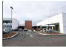
Centro commerciale 2007 Committente: MAVIS S.R.L. Importo lavori: € 3.800.000,00
